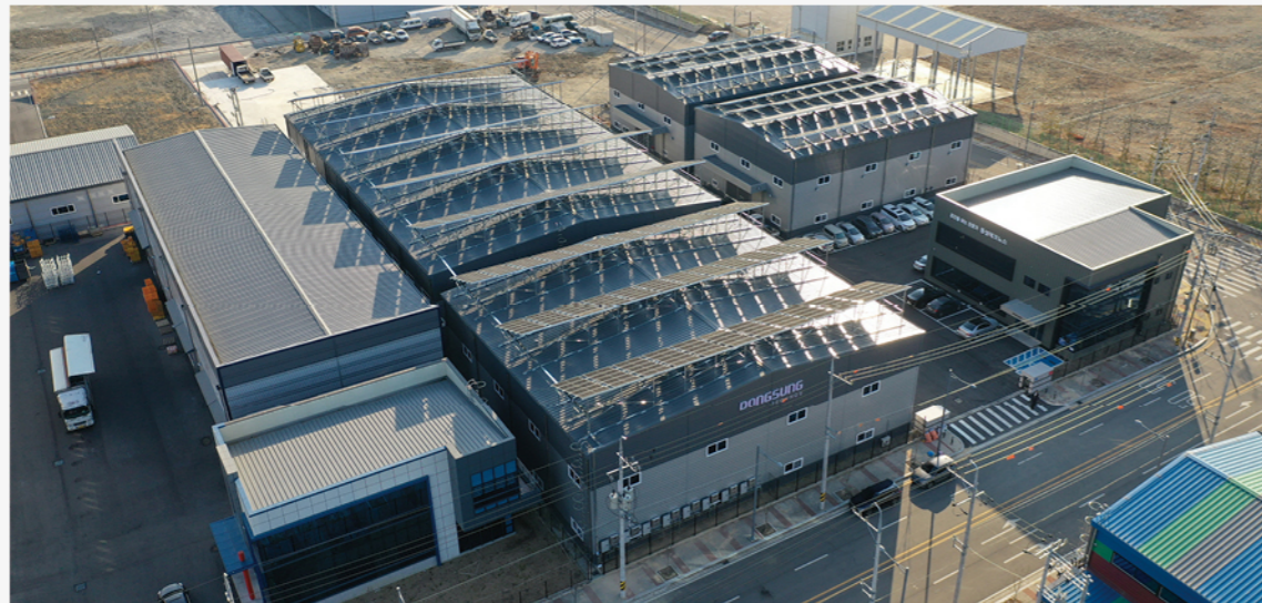
경산 본사(공장) 전경
